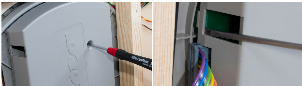
Figuur 3: Kap verwijderen
